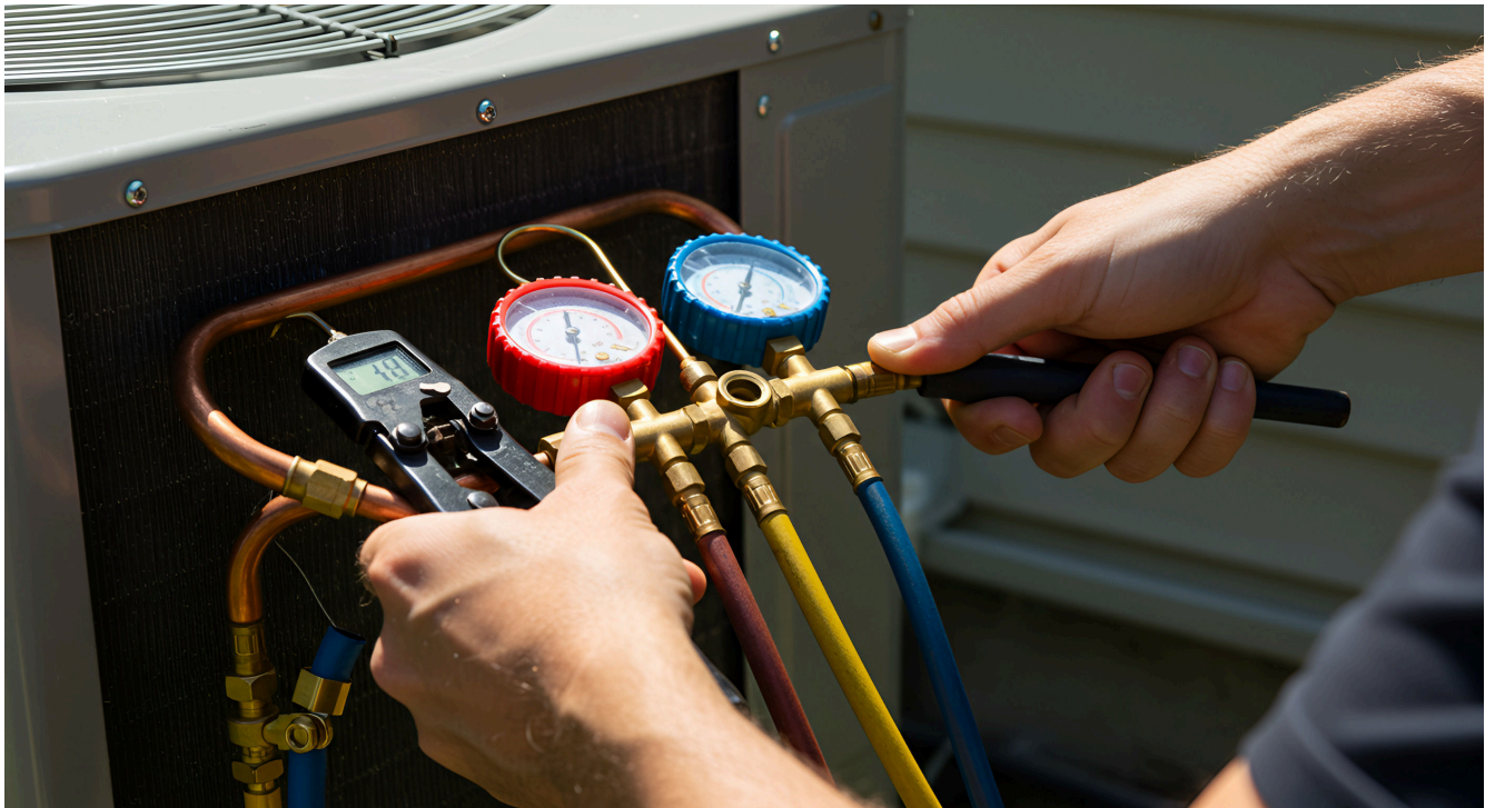
図 1. 冷媒アプリケーションの例
